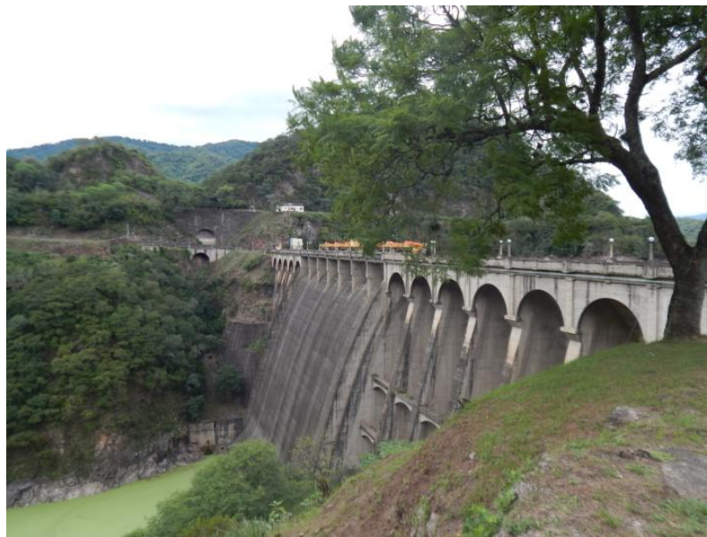
Dique de Escaba, Alberdi, Tucumán (Foto: S. Gamboa Alurralde, 2018).
