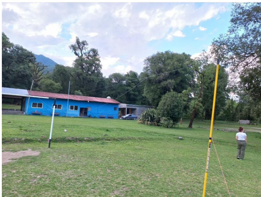
Cochuna 01: vista de las edificaciones del camping (Foto: M.D. Miotti, 2022)
