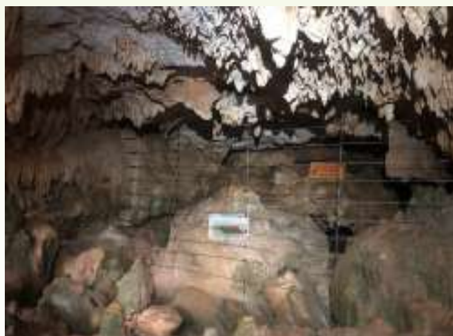
Sistema de exclusión por guayas de acero instalado en la entrada de la cueva Orizjan. El cartel sobre la roca indica el calendario reproductivo de las principales especies de murciélagos habitantes de la cueva. Fotografía: F. Simal.
