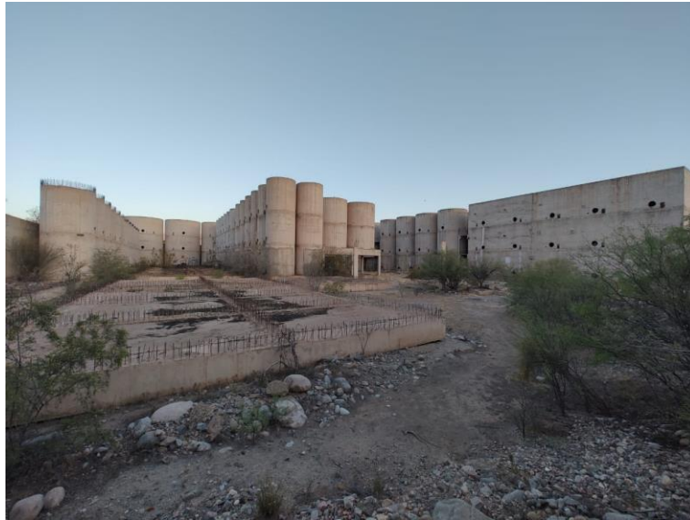
Ex Bodega 01. Vista panorámica de la Ex Bodega (Foto: Alvaro Galban, 2022).
