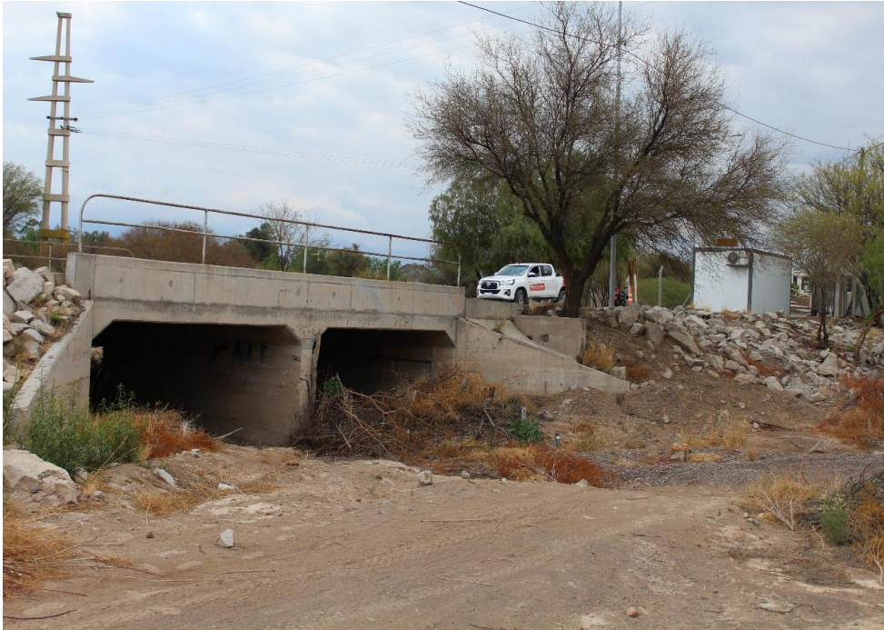
Vista del puente del embarcadero (Foto: Elías Ruiz Estebes, 2022).
