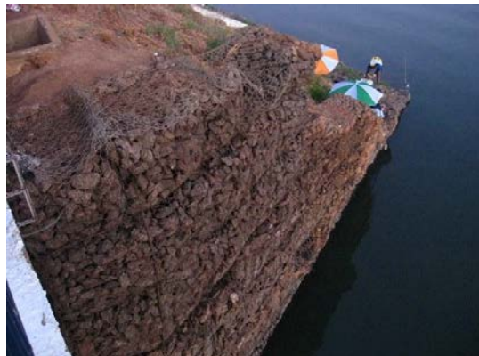
Aterros formados pelos gabiões em uma das áreas contiguas ao continente.
