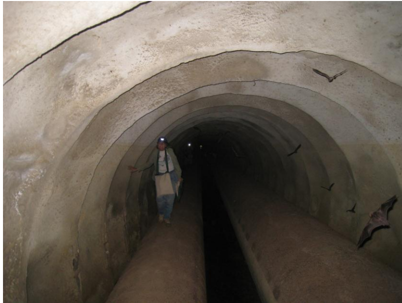
Interior del túnel de aducción, mostrando dos tubos que conducen agua a las ciudades próximas. La investigadora Angela Martino camina sobre uno de los túneles (Foto: Jafet M. Nassar, 2014).
